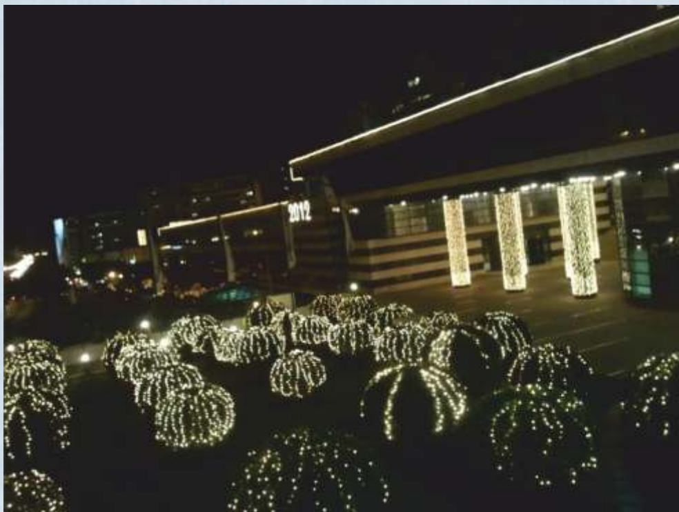
BRODOMERKUR Upravna zgrada
