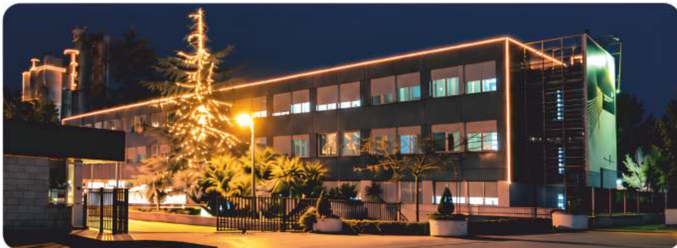
DALMACIJA CEMENT - KAŠTELA
